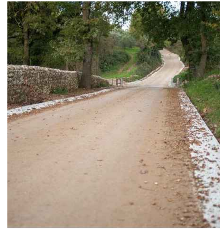
09 Finitura pavimentazione pista ciclabile
